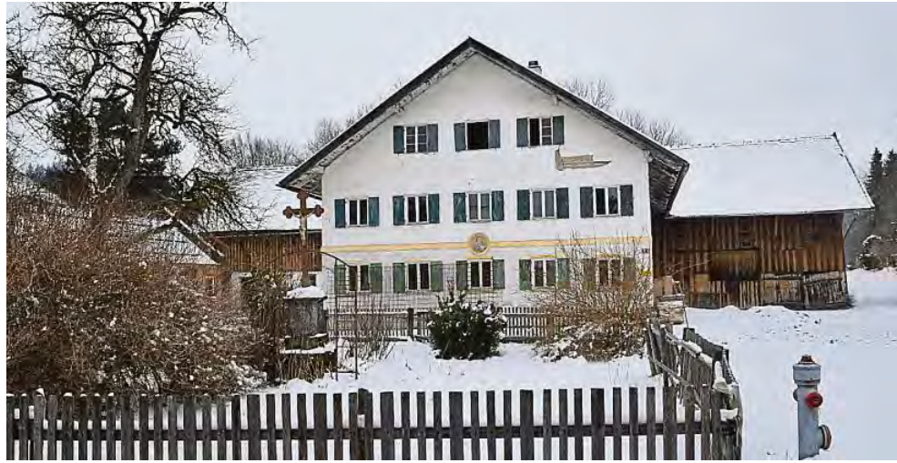
Das landwirtschaftliche Gebäude im Bernbeurer Postweg wird bis auf einen kleinen Teil abgerissen. Eine Sanierung lohnt sich nicht.
